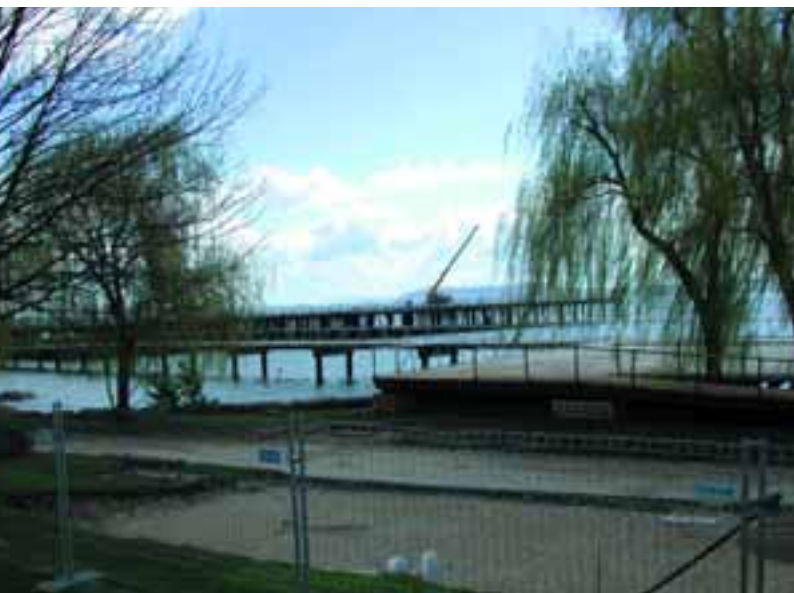
Pour l'heure, c'est le chantier qui prévaut
