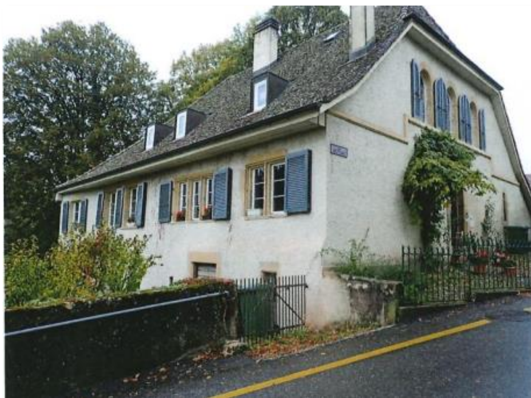
Vy-d'Etraz 2 à Bôle, bâtiment de la Cure
